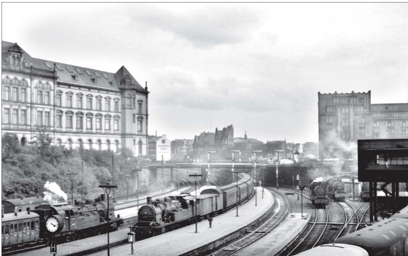
Rauchgeschwängerte Luft liegt am 31.7.1956 über den nach Lübeck und Berlin führenden Gleisen. Ganz links die Gleise der Bergedorfer- und Harburger S-Bahn. Neben der Ansammlung von fünf Loks der Baureihe 78 sind auch die Zuggarnituren beachtenswert. Foto: Kurt Eckert, Archiv Eisenbahnstiftung
