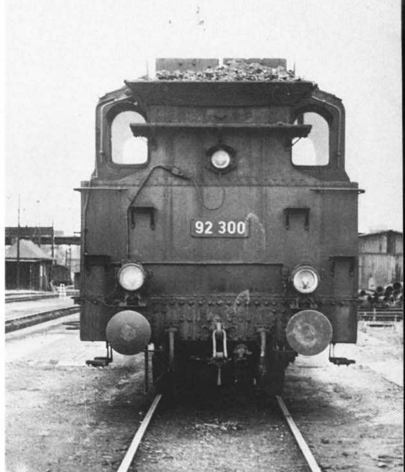
Bild 3: Bei dieser Rückansicht erkennt man sehr gut das in seinem oberen Bereich etwas eingezogene Führerhaus, eines der charakteristischen Baumerkmale dieser Gattung.
