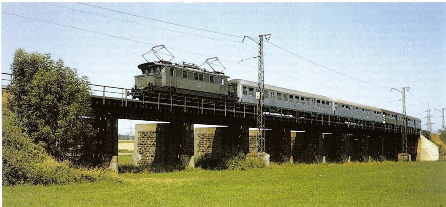
Bild 12: Die Mainflutbrücke bei Hochstadt-Marktzeuln wurde nach 1945 nur behelfsmäßig wiederhergestellt. Die 145 168 (Bw Würzburg) kommt mit dem N 6717 aus Ludwigsstadt am 22. Juli 1983 heran. Zehn Jahre später begann der Brückenneubau – zunächst für das zweite, danach für das bisher benutzte Streckengleis. Abb.: Ch. Roßberg
