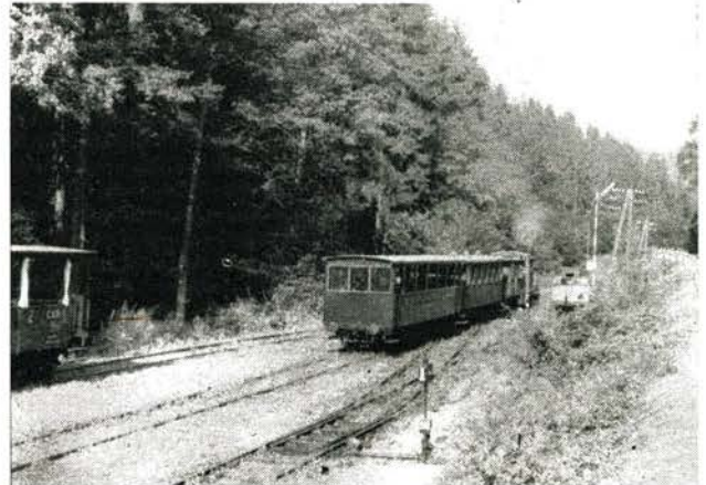
Bild 2 Ausfahrt für den Zug in Richtung Alpinka
