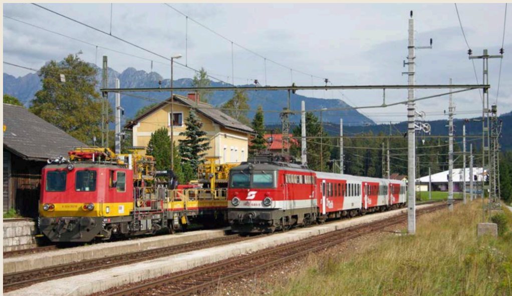
Modernisierung der Fahrleitungsanlagen: Am 14. August 2007 fährt 1142 685 im Bahnhof Kainisch mit dem REX 3429 am Motorgerüstwagen X 554.307 vorbei. Neue Betonmaste sind bereits gesetzt, die alten Maste mit den Querjochen sind noch in Betrieb Eduard Saßmann
