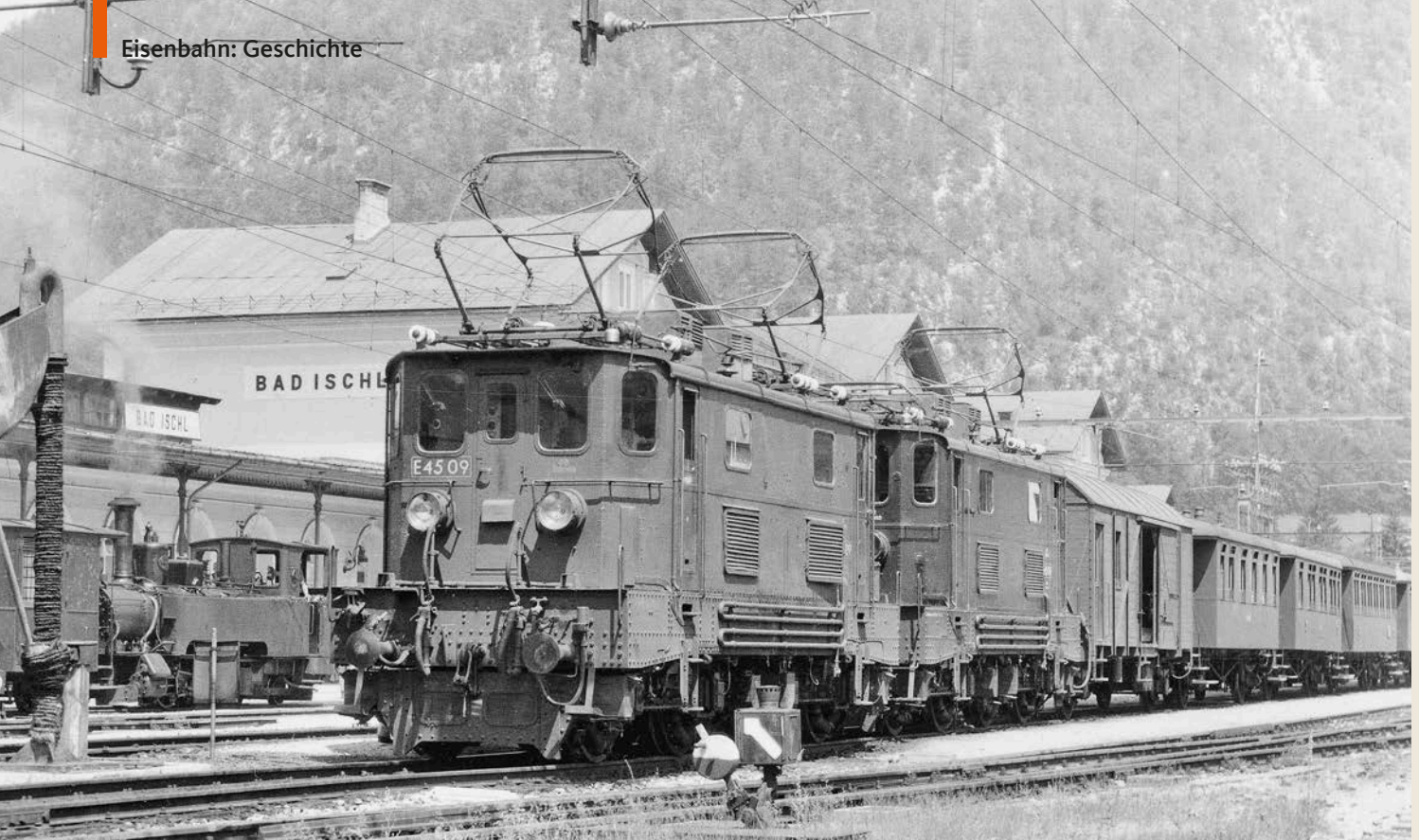
1927 bis 1994 war die BBÖ-Reihe 1170 (spätere ÖBB-Reihe E 45/1045) unverzichtbar auf der Salzkammergutbahn. E 45.09 steht 1952 in Bad Ischl, links ein Zug der Salzkammergut-Lokalbahn F. Kraus/EB-Stiftung
