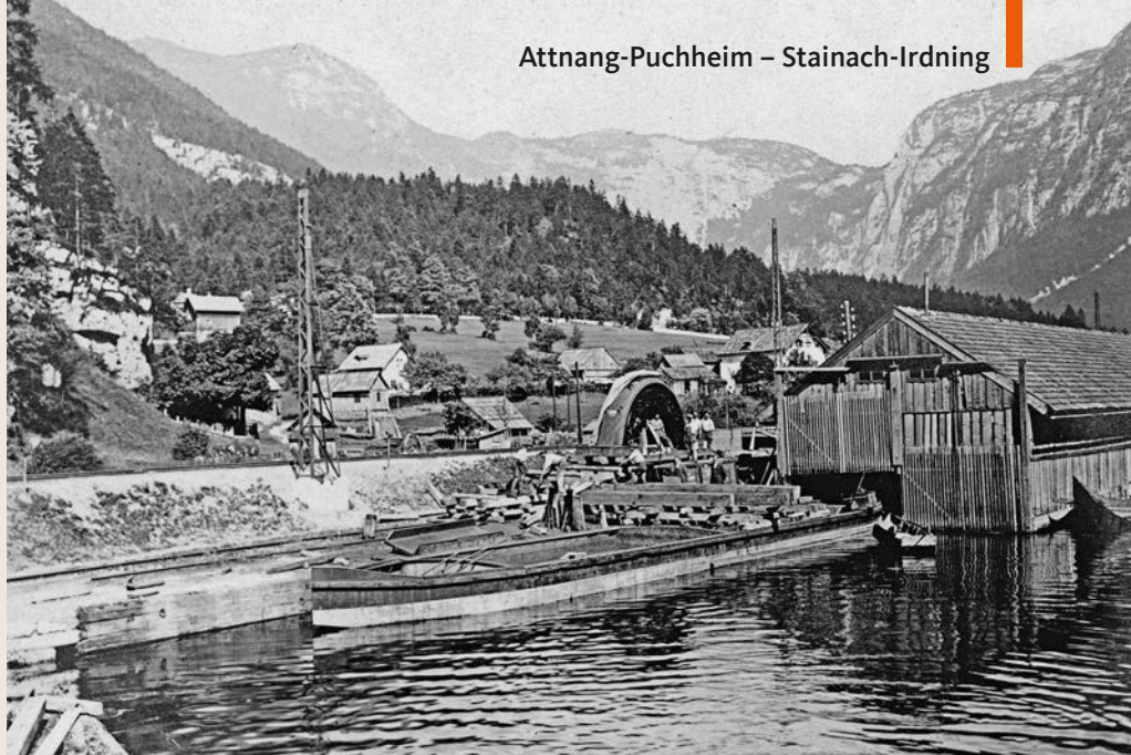
Über die Schleppbahn zum Salz-Hafen am Hallstättersee bei Obertraun-Dachsteinhöhlen werden 1922 Generatoren und Transformatoren für das Kraftwerk und das Schaltheus in Steeg-Gosau auf Schleppkähne verladen und mit Dampfschiffen überstellt Slg. E. Saßmann (2)
