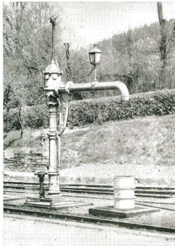
Bild 1 Befindet sich der Wasserkrans in Grundstellung parallel zum Gleis, so ist nach beiden Seiten weißes Licht erkennbar
