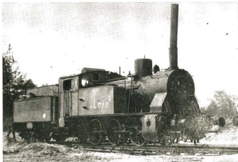
Heute heißt sie „Lore“ und verrichtet auf ihre alten Tage noch treu ihren Dienst als Heizlokomotive im VEB Betonwerk Hennersdorf bei Doberlug-Kirchhain (DDR), die ehemalige 89 1003. Nach Angabe des Bildeinsenders handelt es sich um eine ex pr T 8. Oder kann ein Leser dazu etwas Näheres berichten?
