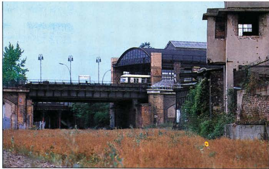
oben: Lehrter Stadtbahnhof, unten: Reste des Lehrter Bahnhofs. Unter der Erde könnte künftig das westliche Verbindungsgleis in Richtung Norden liegen.
