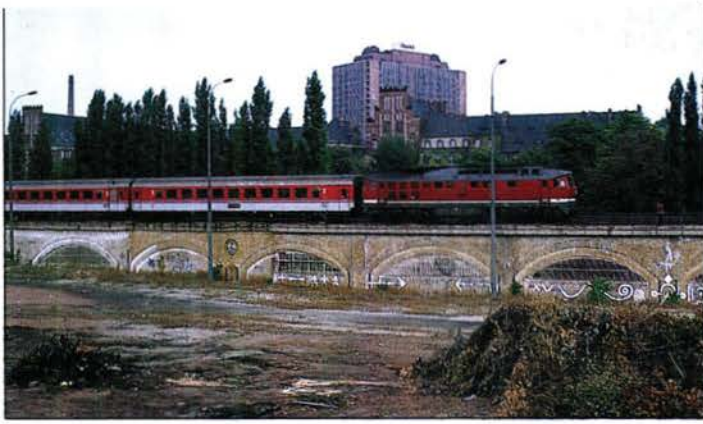
Die Fotos zeigen die Stadtbahntrasse. Hier müßten die neuen Streckengleise aus östlicher und westlicher Richtung in einen Tunnel führen, um dann nach Norden auszuschnellen. Noch vor eineinhalb Jahren stand hier die Mauer.
