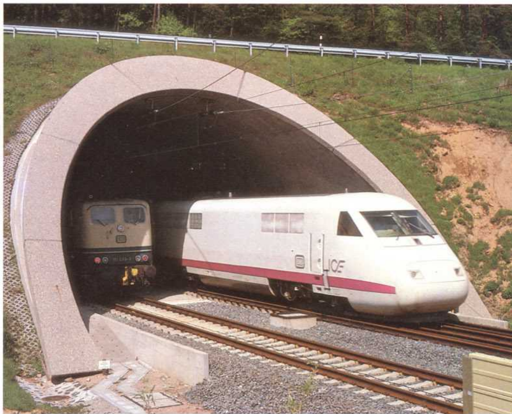
Bild 4: Im Einmalberg-Tunnel wurden am 09.05.1987 Meßfahrten durchgeführt. Dabei raste der ICE mit einer Spitzengeschwindigkeit von bis zu 280 km/h an einem stehenden Güterzug vorbei. Foto: K. Trabold
