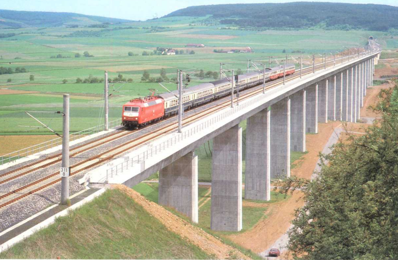
Bild 10: Seit dem 29.05.1988 benutzen die Intercity-Züge zwischen Würzburg und Fulda die Neubaustrecke. Der IC 682 "Albrecht Dürer", gezogen von der 120 131, überquert gerade die Leinachtalbrücke bei Zelllingen. Foto: A. Schöppner
