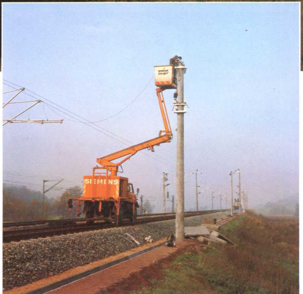
Bild 8 und 9: Bei den Elektrifizierungsarbeiten auf der NBS kamen neben den DB-Turmtriebwagen der Baureihen 701/702 auch Fahrzeuge privater Firmen zum Einsatz. Beide Aufnahmen entstanden im November 1986 in der Nähe von Burgsinn. Fotos: A. Ritz
