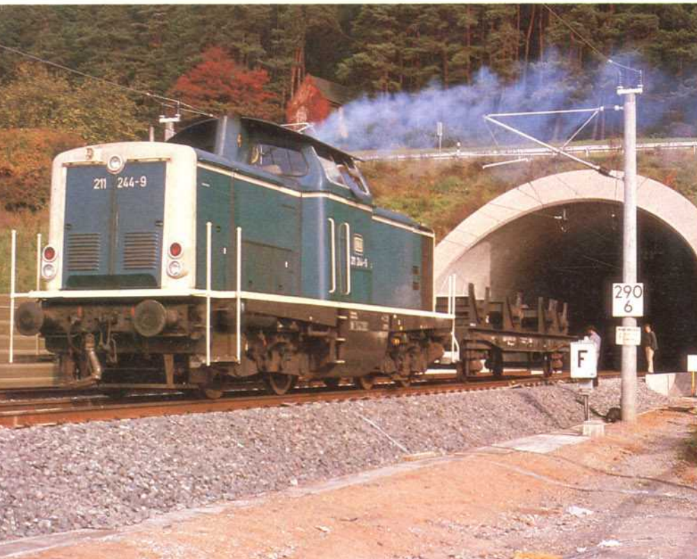
Bild 7 (unten): Die 120 133 verläßt gerade mit einem Meßzug den Landrücken-Tunnel. Er ist mit 10 780 m nun der längste auf dem bundesdeutschen Schienennetz. Foto: K. Trabold
