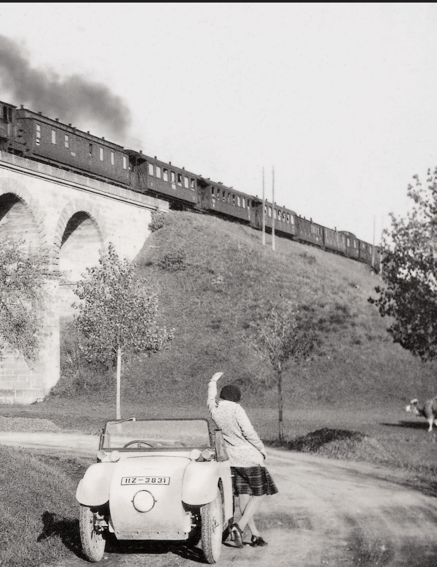
Eine Tenderlok der bayerischen Gattung Pt 2/5 N überquert im Jahre 1928 mit einem Personenzug die Wurnbachbrücke im Verlauf der Strecke Gunzenhausen – Nördlingen. Unterhalb steht ein uriges Gefährt vom Typ Hanomag. Der Zweisitzer wurde im Volksmund „Kommissbrot“ genannt. FOTO: L. EHRSAM/SAMMLUNG WUNSCHEL
