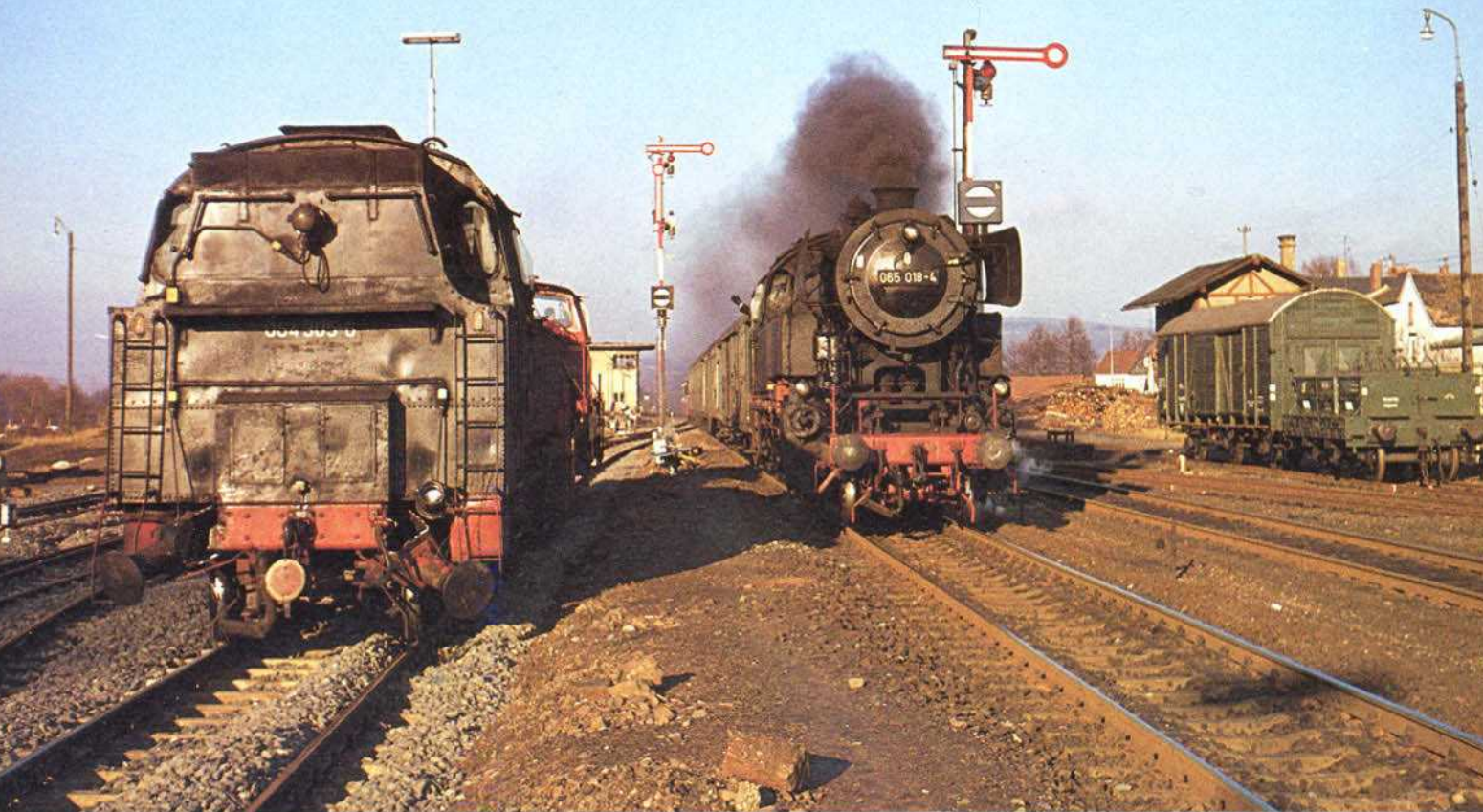
Bild 1: Die 065 018 fährt im Oktober 1972 mit einem Personenzug aus Aschaffenburg soeben in den Bahnhof Obernburg-Elsenfeld ein. Nach Abkuppeln der Schienenbusgarnitur am Zugschluß wird die 065 018 ihre Fahrt nach Miltenberg fortsetzen. Links steht die 064 305. Foto: G. Goerke
