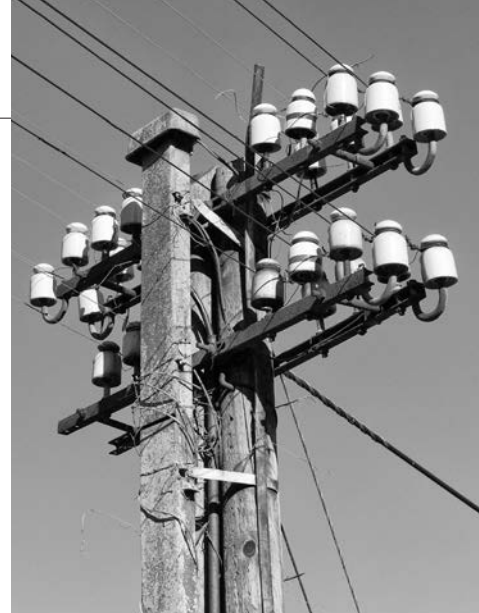
Telegrafenermast-Detail im Ahrtal.
