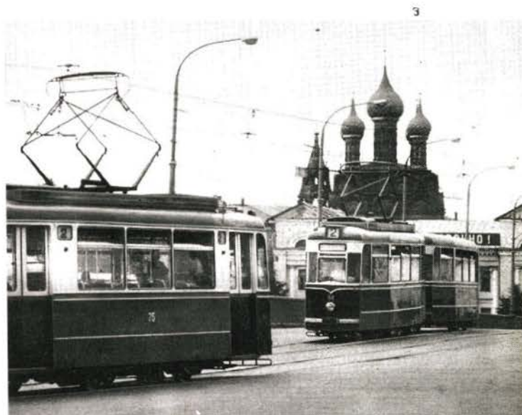
Bild 1 Moskau, Linie 23, auch diese Wagen sind für den Kehrschleifenbetrieb umgerüstet, so haben sie nur noch auf einer Seite Türen
