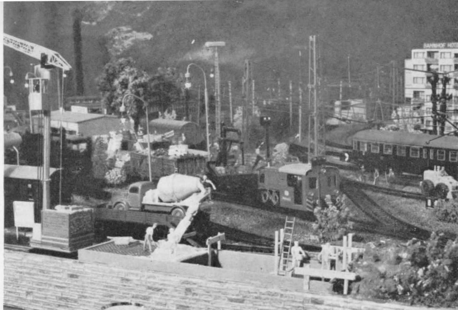
Abb. 1. Ein Motiv von der „MALEGERA“, das im Vordergrund einen Hallen-Neubau und dahinter den ersten Lok-Selbstbau der „MALEGERA AG“, ein Modell der Köf II, zeigt.
