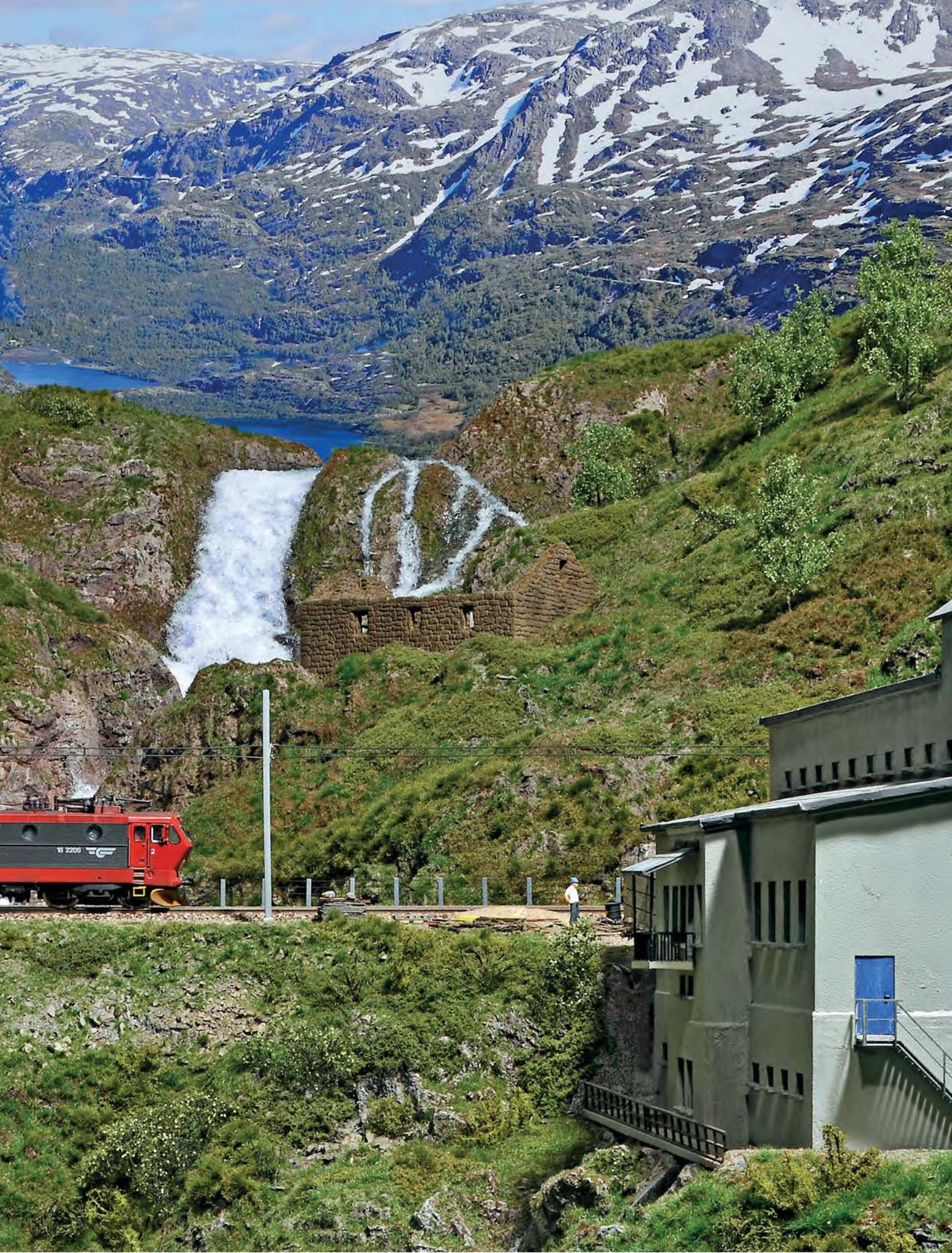
Unbändig schießen die Wassermassen den Kjosfossen hinunter, fast 100 m tief ist ihr Fall. Unterhalb der Flämsbahn wird die Energie gebändigt und bringt so die Züge hinauf nach Myrdal.
