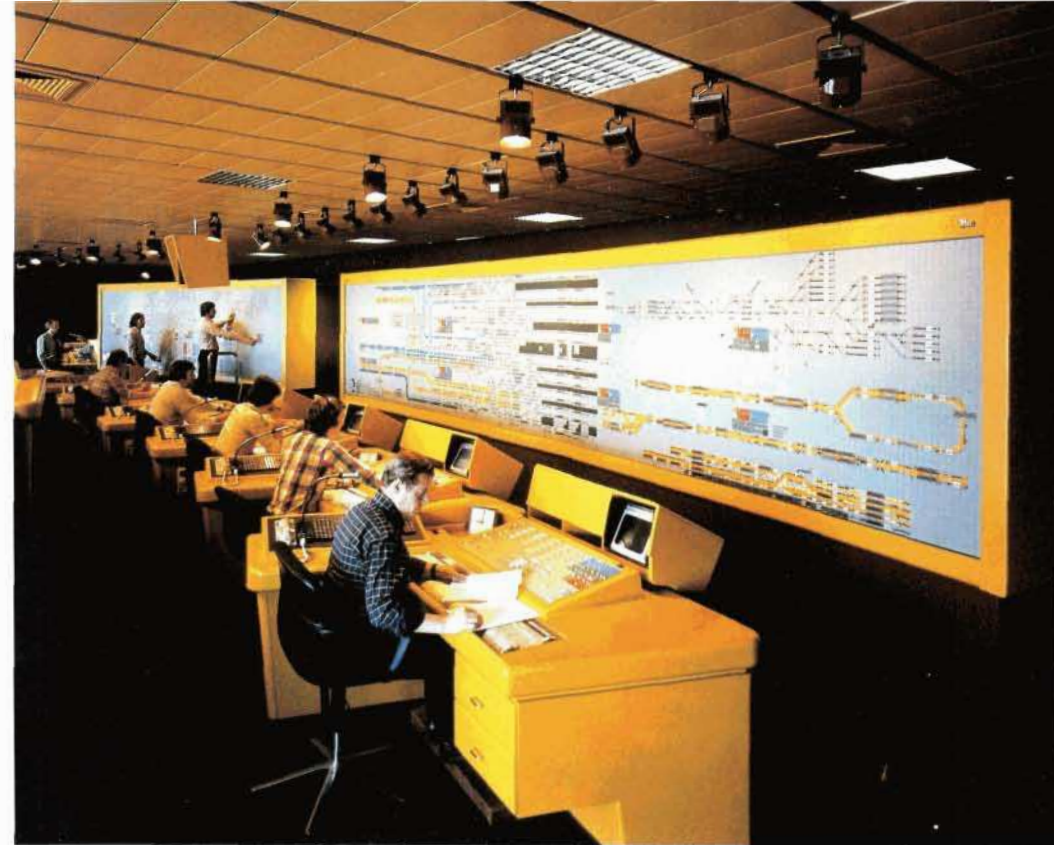
Bild 12: Das im Oktober 1977 eingeweihte Zentralstellwerk des Stuttgarter Hauptbahnhofs ersetzte zwölf alte Stellwerke aus den zwanziger Jahren.
