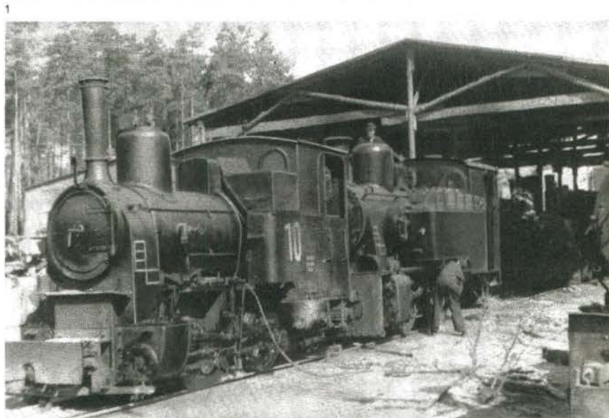
1—3 Die unterschiedlichsten Loktypen waren beim Bau des Berliner Außenringes über den Templiner See eingesetzt. Die 1956 aufgenommenen Maschinen gehörten der damaligen Bauunion Berlin.
