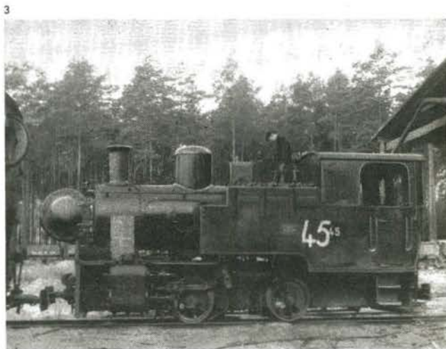
4 1908 lieferte Henschel diese Lok der Bauart Cn2t, die später zur Werkbahn des Braunkohlentagebaues Großräschen gehörte. Noch 1950
