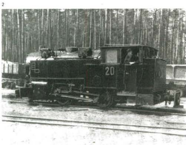
4 1908 lieferte Henschel diese Lok der Bauart Cn2t, die später zur Werkbahn des Braunkohlentagebaues Großräschen gehörte. Noch 1950
