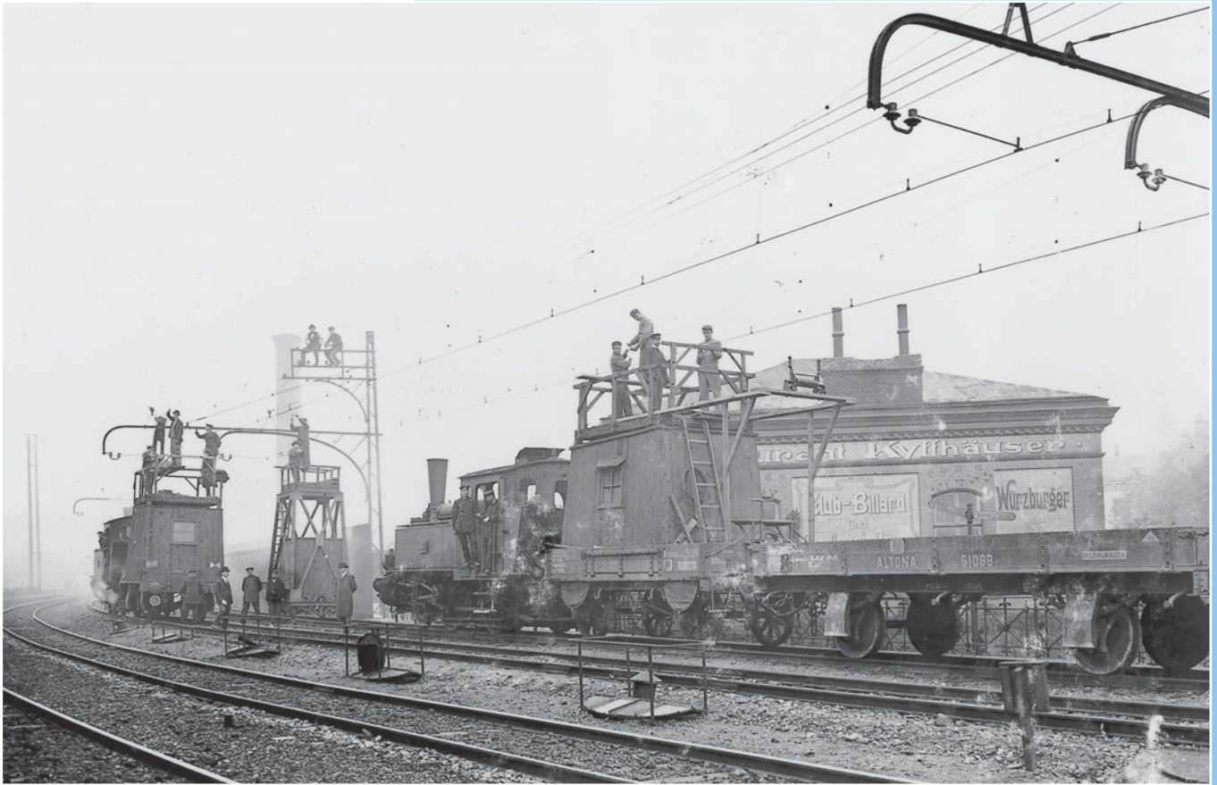
Bauarbeiten zur Länderbahnzeit: Das Foto entstand 1906 bei der Elektrifizierung der Hamburg-Altonaer Stadt- und Vorortbahn Blankenese–Hamburg–Ohlsdorf. Die Lok vor dem Arbeitszug (in Bildmitte) ist eine alte preußische T 4. Foto: Archiv MIBA
