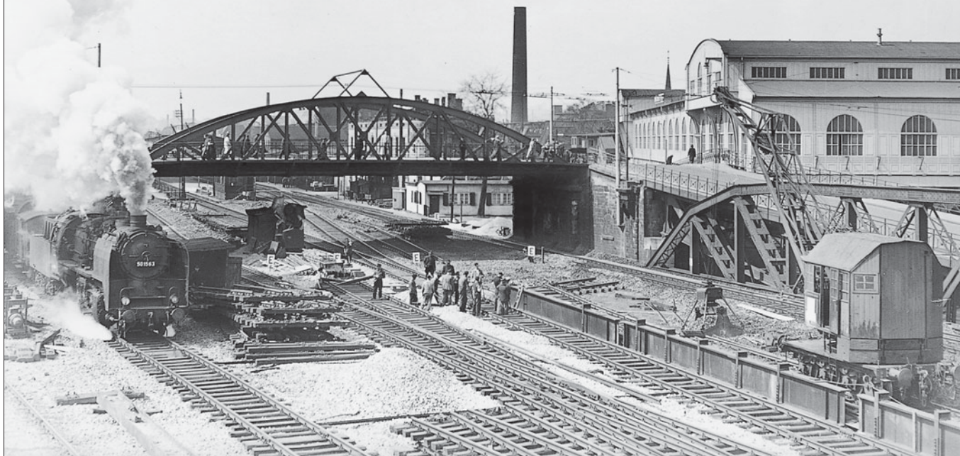
Gleisumbauten bei laufendem Betrieb: Am 23. Mai 1951 fotografierte Altmeister Carl Bellingrodt 50 1563 mit einem Güterzug beim Passieren einer Baustelle in Oberbarmen (Wuppertal). Rechts ein als Bagger tätiger Kranwagen. Foto: Archiv MIBA
