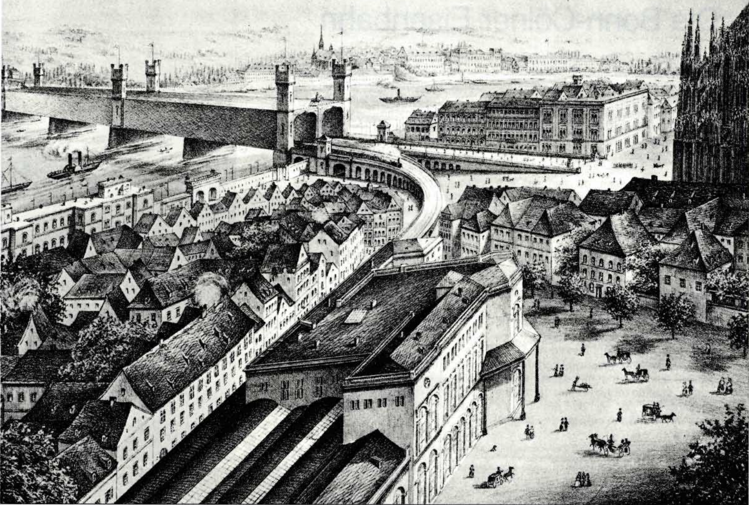
Bild 12: Die neue Rheinbrücke und der Central-Bahnhof im Jahre 1859. Im Hintergrund, am Anfang der Brückenrampe, das Direktionsgebäude der Cöln-Mindener Eisenbahn. Zeichnung: Wüsteneck, Sammlung Perillieux
