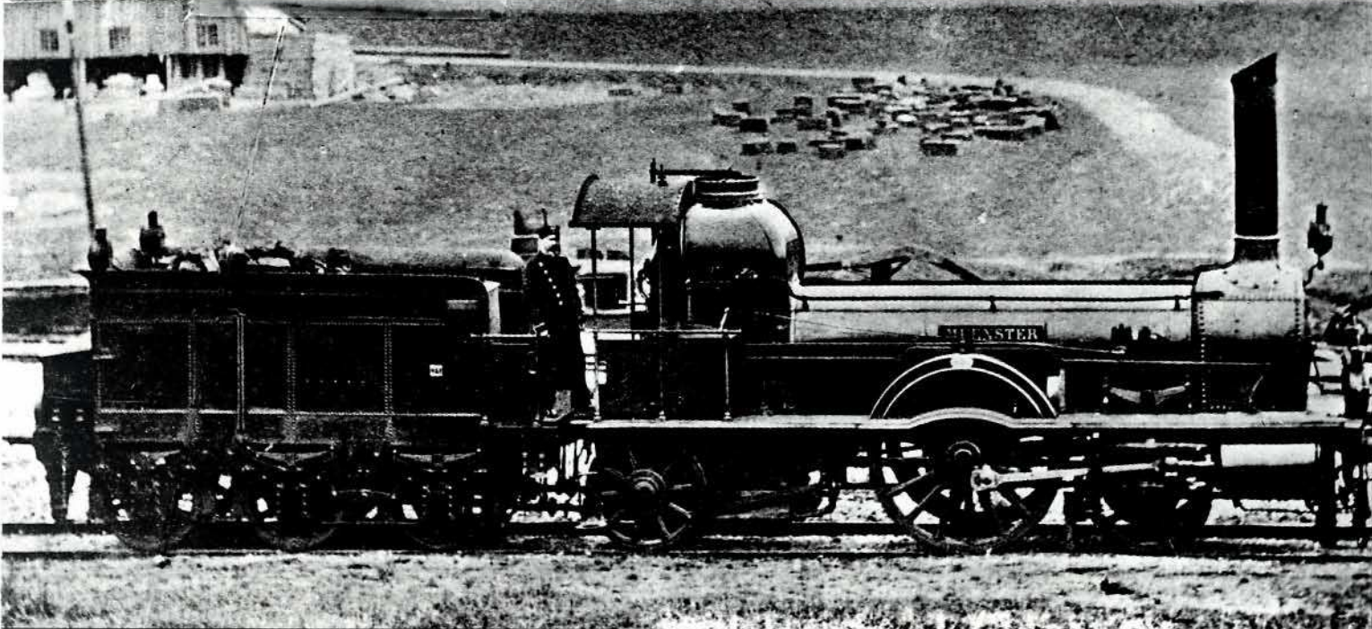
Bild 7: Für die Köln-Mindener Eisenbahn hat Kessler 1848 noch in seiner Werkstätte in Karlsruhe als Fabriknummer 101 die „Münster“ gebaut. Sie hatte zunächst einen überhängenden Stehkessel, erst 1851 wurde die hintere Laufachse nach rückwärts versetzt, um so einen längeren Radstand zu erreichen. Foto: Sammlung Dr. Scheingraber
