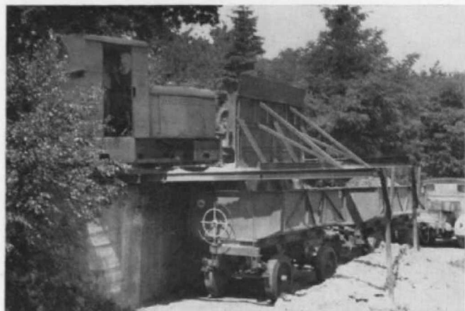
Abb. 5 zeigt deutlich die Kupplung und die Sicherung der Kipploren. Die Lore rechts weist sogar einen kleinen Bremsersand auf (eine weitere Anregung für Egger!).
