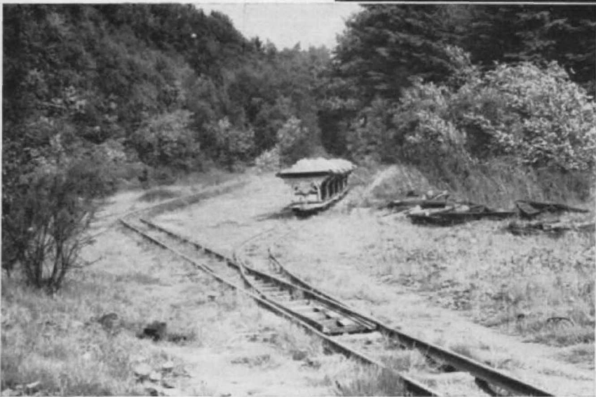
Abb. 8. „Die Fahrt ist keineswegs zu Ende, im Gegenteil das Bild spricht Bände“ . . . über die richtige Verlegung von Egger-Gleisen und -Weichen. Da, wo die Gleise schon lange liegen, sind die Schwellen halb oder ganz ins Erdreich eingedrückt, während sie in der Grube selbst oben auf liegen (s. Abb. 9). Feldbahngleise werden in keinem Fall eingeschottert! Dagegen sollte man nicht vergessen, tüchtig Gras und Unkraut zwischen die Schwellen zu „säen“. Die verschiedenen Grasmatten im Verein mit Streugras werden uns hier sicher gute Dienste tun!
