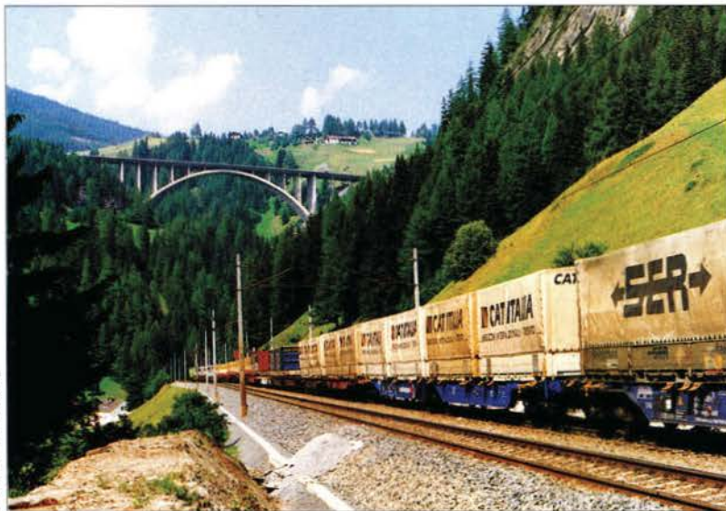
Wettbewerbsgleichheit? Während sich Güterzüge über die 125jährige Brennerbahn schlängeln, überspannt die Brenner-Autobahn ganze Täler.
