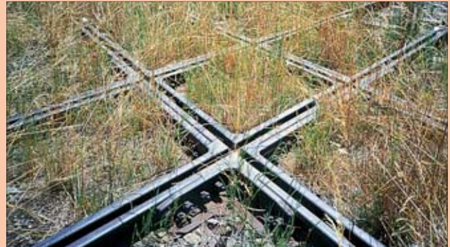
Die kleine Remise und der Wasserturm stehen heute noch. Unten eine Detailaufnahme einer der drei Kreuzungen im Wendestern. Statt vieler Radlenker sind durchgehende Rillenschienen verlegt.
