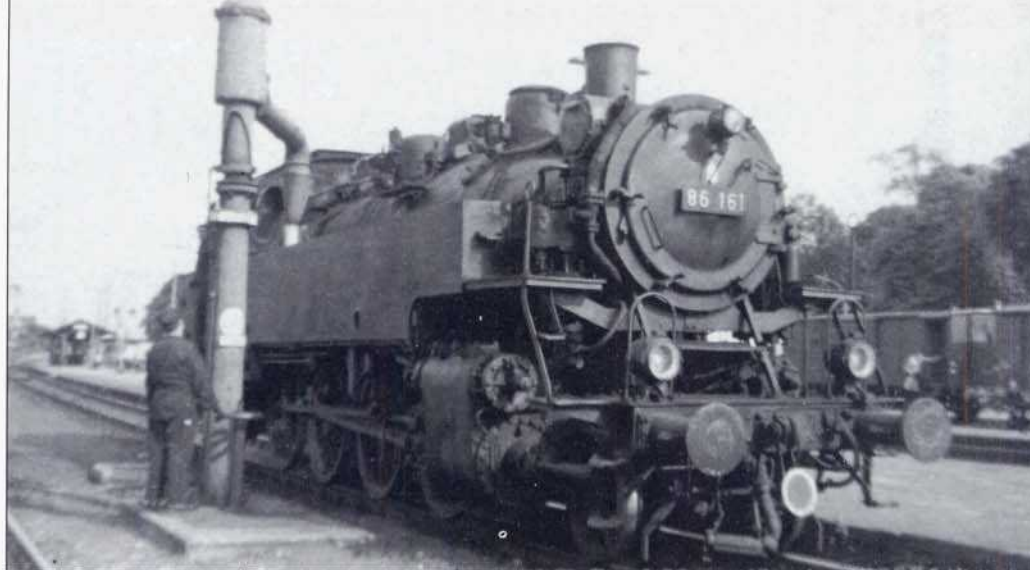
Bild 3: Ab Mitte der dreißiger Jahre wurden Lokomotiven der Baureihe 86 eingesetzt. Sie liefen bis zum Ende des Dampfbetriebs. Hier die 86 161 beim Wasserfassen in Haßfurt. Foto: P. Melcher
