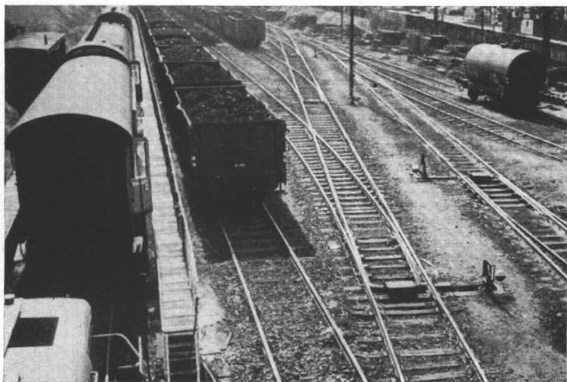
Abb. 2. Die Freiluft-Wagenwaschanlage in Würzburg.
