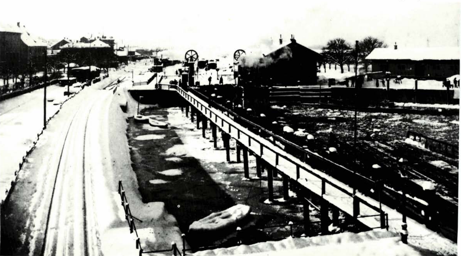
Bild 12: Die Fähranlage im Winter. Rechts neben dem Steg liegt ein Fährschiff zur Übernahme von Güterwaggons bereit. Links im Bild die Strecke von Bregenz nach Lindau. Foto: Sammlung Lampert
