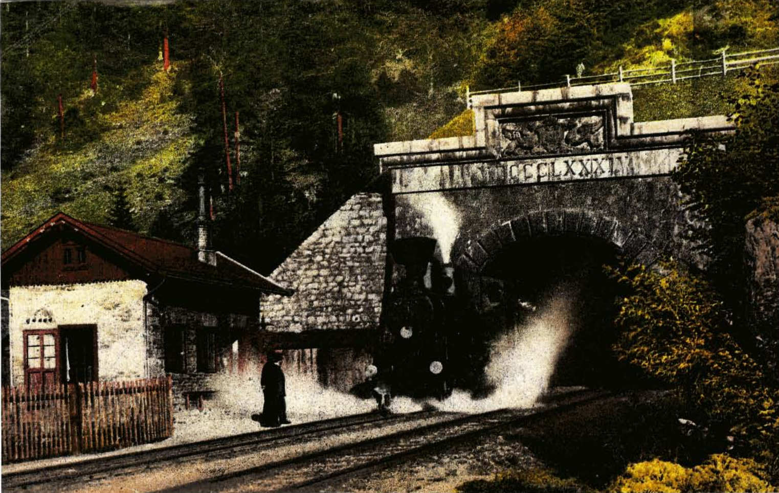
Bild 3: Lokomotive der Serie 60 vor dem Westportal des Arlbertunnels. Links das Wächterhaus des Tunnelwärters.
