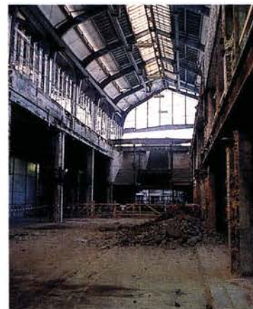
Sanierung des Gewölbes im Bahnhof Friedrichstraße.
