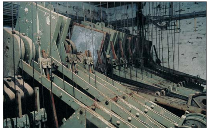
Im Stellwerk „Mwf“ befinden sich die Spannwerke für Weichen und Signale im Spannwerksraum unterhalb der Hebelbank. Die Drahtzugleitungen kommen nahezu senkrecht „aus der Decke“ und werden nach Verlassen der Spannwerke waagrecht und mit geringem Abstand über dem Boden in die Gruppenablenkung geführt. Der beengte Platz lässt nur diesen fotografischen Blick auf die Signalspannwerke zu.
