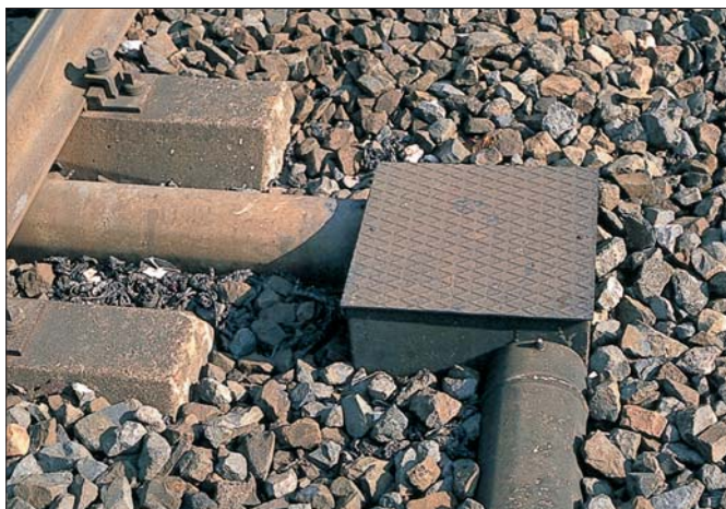
Müssen Drahtzugleitungen Gleise queren, werden sie über Kanäle in Ablenkungen geführt, sodass sie zwischen den Schwellen das Gleis im 90°-Winkel passieren können.
