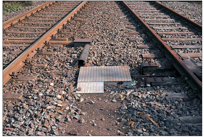
Oben links: Eine Doppelleitung wird in einen kurzen Blechkanal-Abschnitt und von dort aus in den Weichenantrieb geführt. Auch hier sind die unterschiedlichen Farbnuancen beachtenswert: Kanal hellgrau, Weichenantrieb rostfarben und Druckrolle (rechts oben im Bild) schwarz. Rechts daneben Kanäle und Antriebe in unterschiedlicher Farbgebung.
