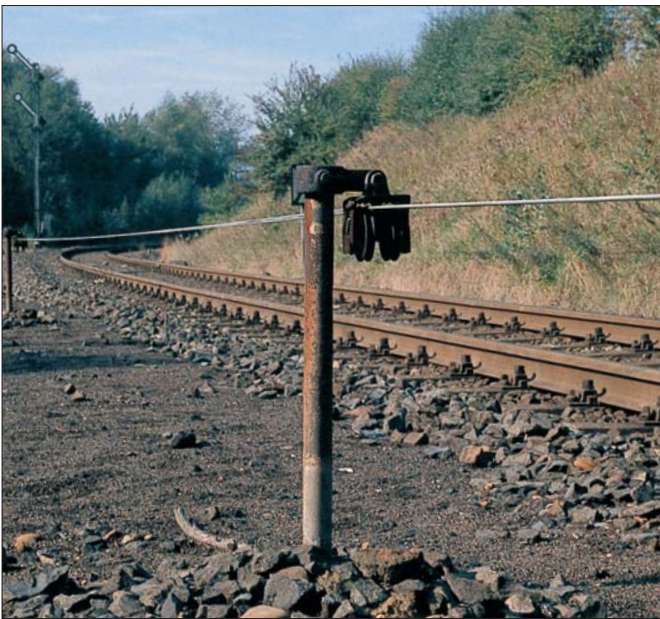
Hier werden mehrere Leitungen in einen Kanal zusammengeführt, wo sie wenig später abgelenkt werden um ein Gleis zu kreuzen.
