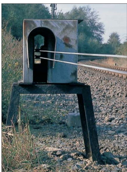
Müssen Drahtzugleitungen Gleise queren, werden sie über Kanäle in Ablenkungen geführt, sodass sie zwischen den Schwellen das Gleis im 90°-Winkel passieren können.
