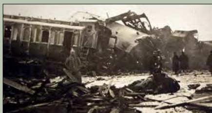
Auch von Unfällen blieb der Bahnhof Ottersberg nicht verschont: Das schwere Zugunglück vom 30. Dezember 1906 forderte fünf Menschenleben.
