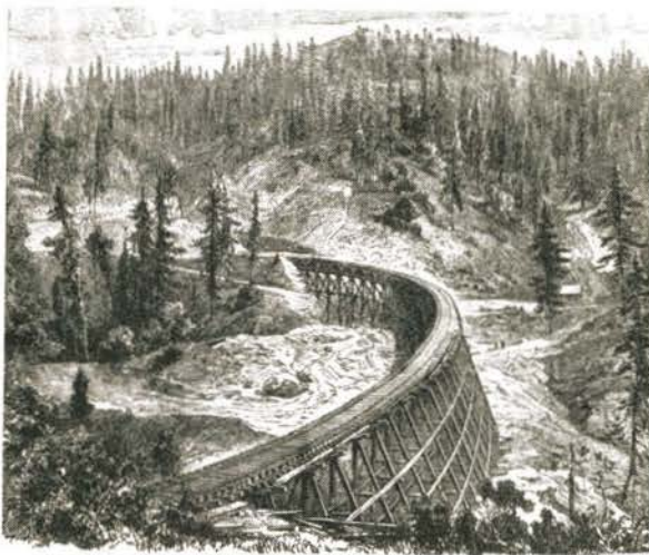
Bild 57 Holzgerüste als Unterbau in Amerika (trestle works)
