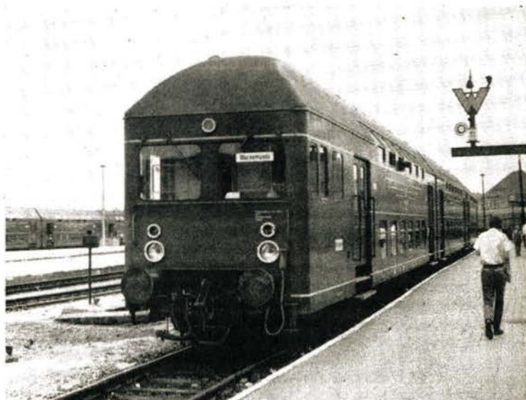
Bild 3 Die Steuerabteile der Stadtbahnzüge sind vielfach mit Fahrtrichtungsanzeiger versehen
