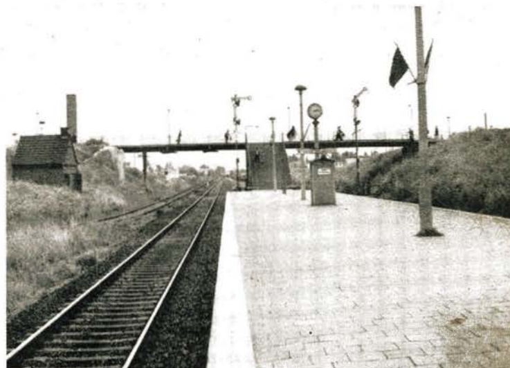
Bild 4 Die Einfahrtsignale zum Bahnhof Rostock-Bramow, die am südlichen Ende des Bahnsteigs Rostock-Marienehe stehen. Wegen des nach Vollendung der 1. Ausbaustufe vorübergehend eingerichteten Linienbetriebes wurde an jedem der beiden Streckengleise je ein Signal aufgestellt, rechts für das Streckengleis von Lütten Klein Süd, links für das von Warnemünde, welches heute nur noch bei Einfahrten vom falschen Gleis benutzt wird.
