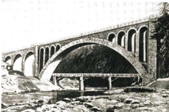
Bild 59 Eisenbahnbrücke über den Pruth
