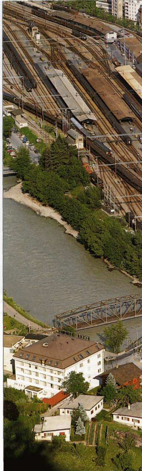
Bild 3: Panorama der Bahn-Anlagen in Brig. Zwischen den Normalspurgleisen der BLS und der SBB (links) sowie den Schmalspurgleisen der BVZ und FO (rechts) liegt das Empfangsgebäude. Die BVZ-Strecke verschwindet am rechten Bildrand hinter dem Depot der FO. Foto: K. Fader
