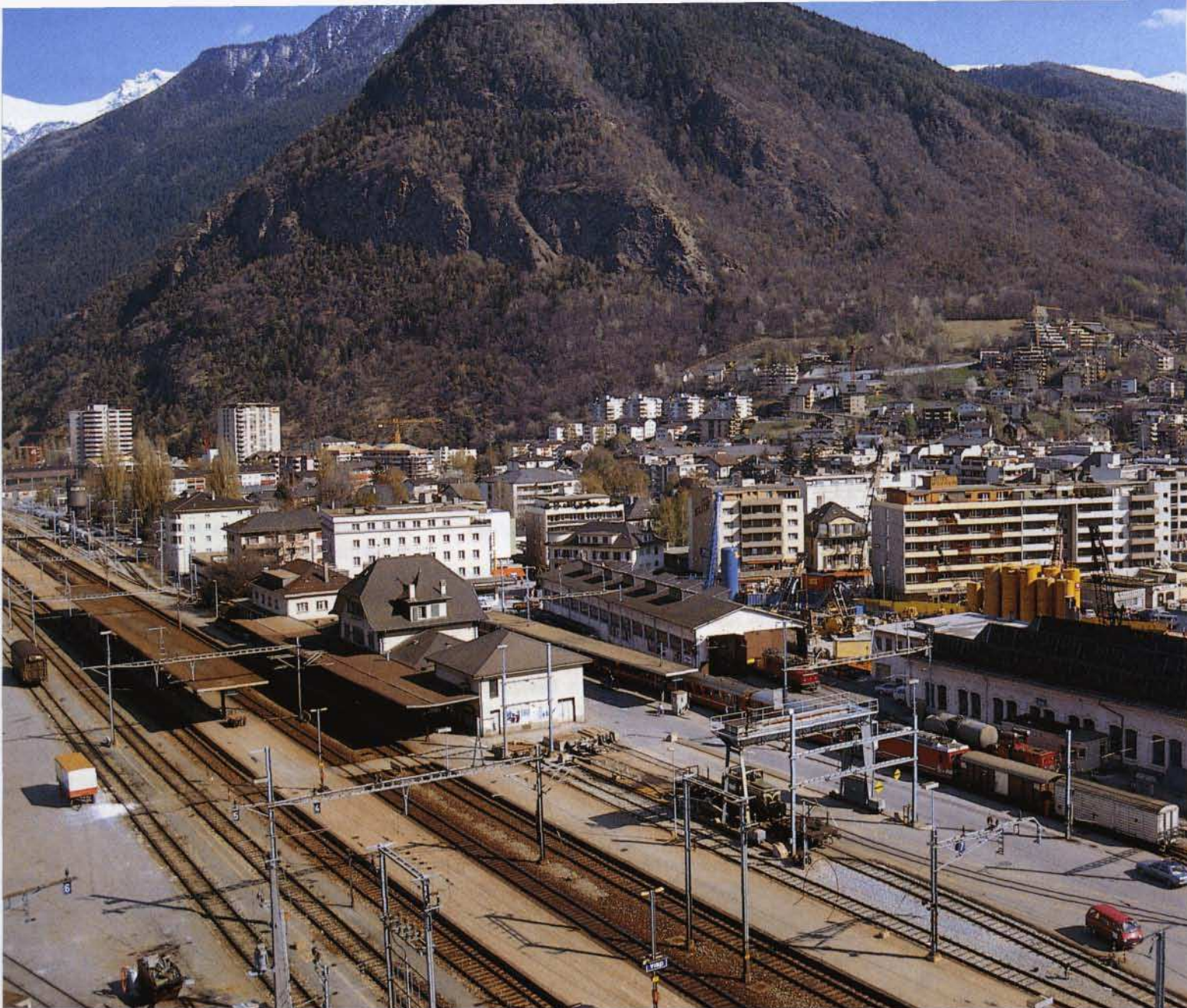
Bild 7: Nach 9 km Fahrt durchs Rhonetal erreicht der in Richtung Zermatt fahrende Zug den Bahnhof Visp. Visp ist erst seit dem Bau der Verbindungsbahn zur FO in Brig (1930) Durchgangsstation der BVZ. Deshalb befinden sich hier Depot- und Werkstattanlagen der BVZ. Gut erkennbar das zwischen den Gleisanlagen der Schmalspurbahn und der Schweizerischen Bundesbahnen als Inselbahnhof erbaute Empfangsgebäude von Visp. Foto: M. Lasek
