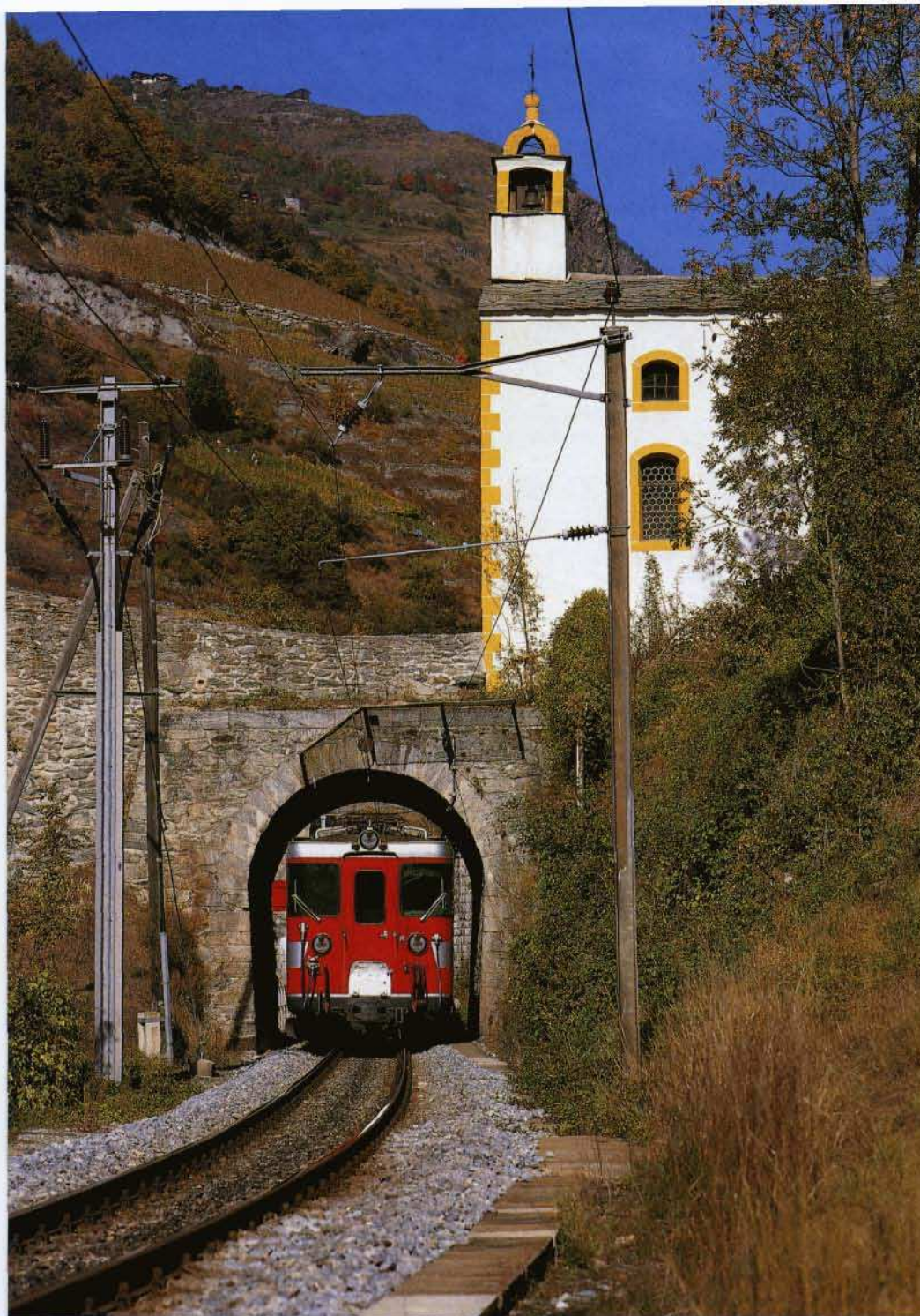
Bild 10: In einer langgezogenen Kurve führt die Strecke bei Neubrück an der Vispa entlang – einer besonders romantischen Stelle an der BVZ-Trasse. Foto: K. Fader
