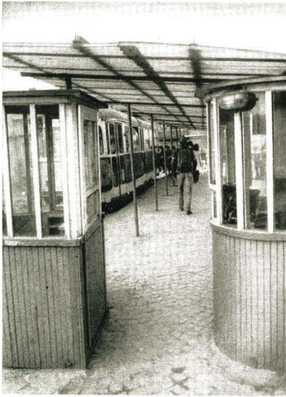
Bild 6 Bahnsteigüberdachung und Sperrenhäuschen an der Endschleife Litvínov
