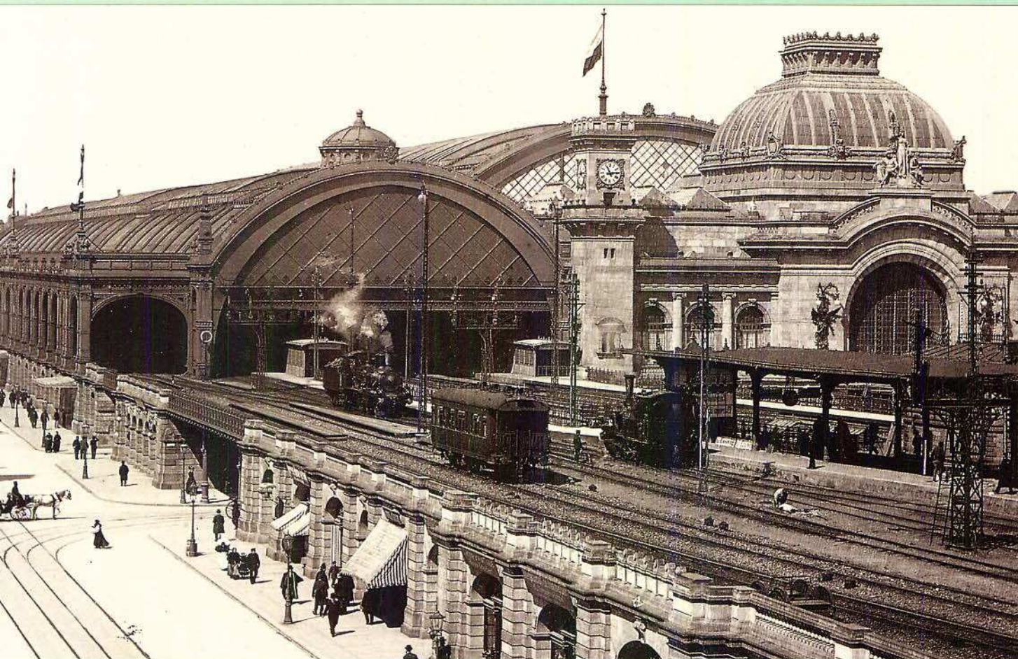
Bild 7: Auf dieser faszinierenden Abbildung des Dresdner Hauptbahnhofs von der Jahrhundertwende ist neben je einer Lokomotive der Gattungen VIII 2 und VII T noch viel Lokalkolorit der damaligen Zeit zu erkennen. Abb.: Sammlung Grundmann
