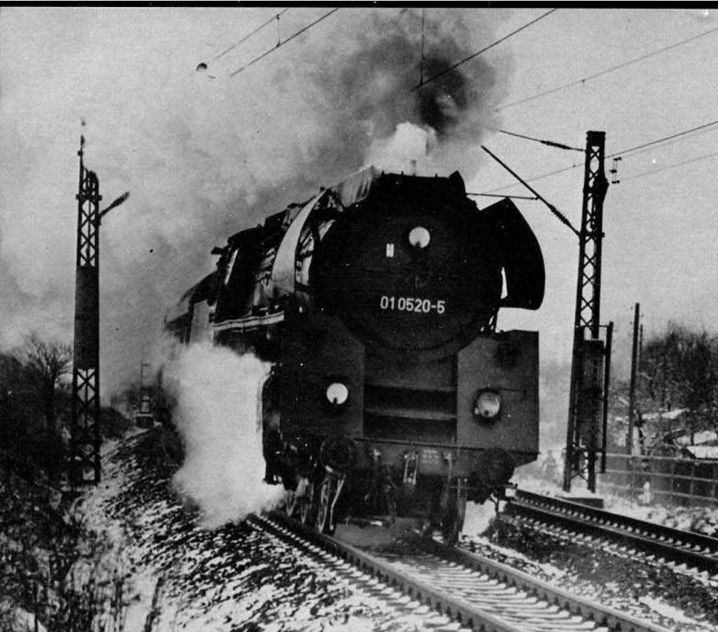
Bild 4: Die 01520 (ex 01162) in schwerem Schnellzugdienst auf der Strecke Saalfeld-Gera-Leipzig. Auch diese Maschine hat schon die Rauchkammertür der Einheitsbauart erhalten.
