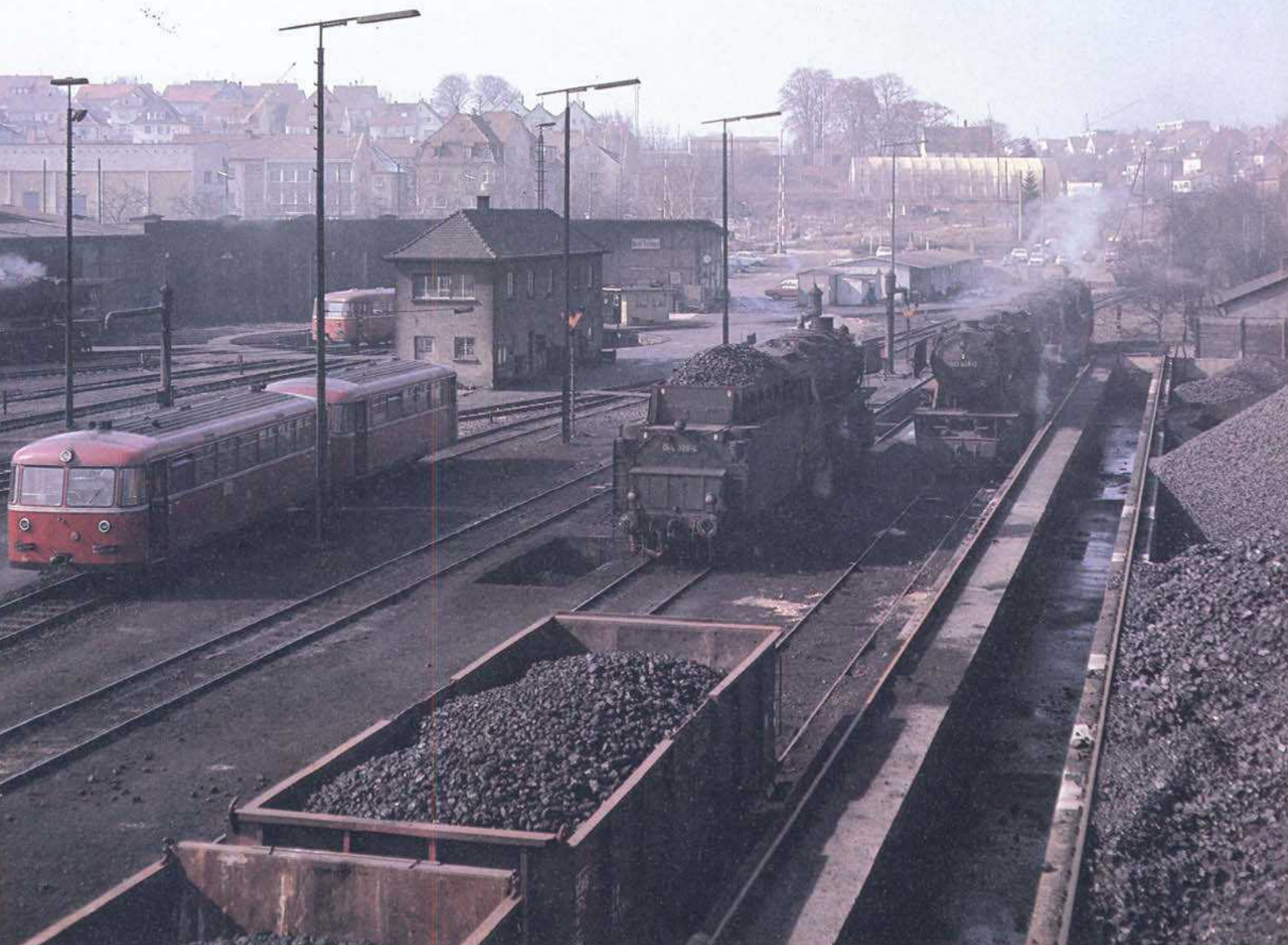
Bild 1: Blick vom Kohlenkran auf das Bw-Gelände mit dem Ringlokschuppen im Hintergrund. Soeben war ein einmotoriger Schienenbus der Baureihe 795 eingefahren.
