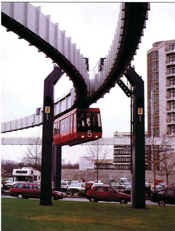
Die Weichen: Vor jedem Bahnhof teilt sich die Strecke, um Bewegungen zu ermöglichen.
