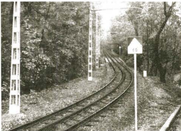
Bild 4 Streckenabschnitt mit Neigungsanzeiger, der für den folgenden 60 m langen Abschnitt eine Steigung von 93 ‰ ankündigt
