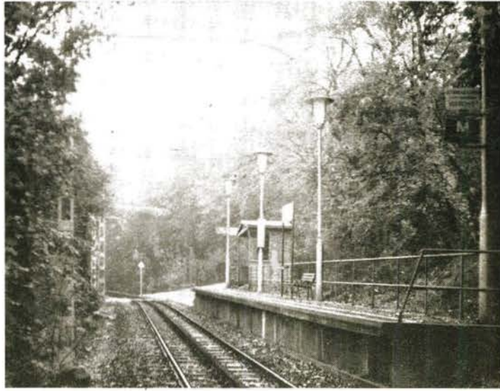
Bild 5 Hp Müvesz ut, die überhöhte Bahnsteigkante ist gut erkennbar, die das Einsteigen ohne Zwischenstufe ermöglicht
