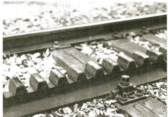
Bild 7 Die neue Riggenbachsche Zahnstange mit trapezförmigem Zahnquerschnitt
