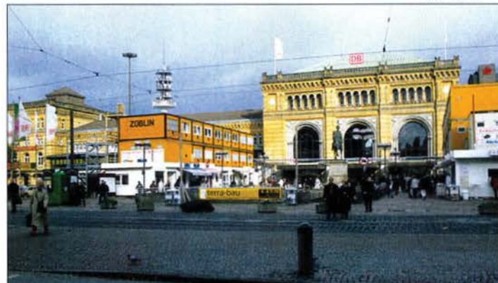
Einer Großbaustelle gleicht der Bahnhof der niedersächsischen Landeshauptstadt.
