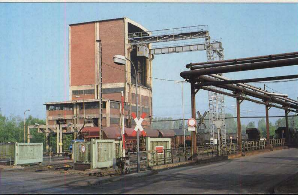
Bild 2: Die Verladeeinrichtung für den Hausbrand des "EBV", fotografiert am 6. Mai 1988. Sie ist eine von vielen Anschlüssen, die täglich von den Werklokomotiven bedient werden. Sie dürften sicher, wenn auch in erheblich vereinfachter Form, für den Modellbahner interessant sein.
