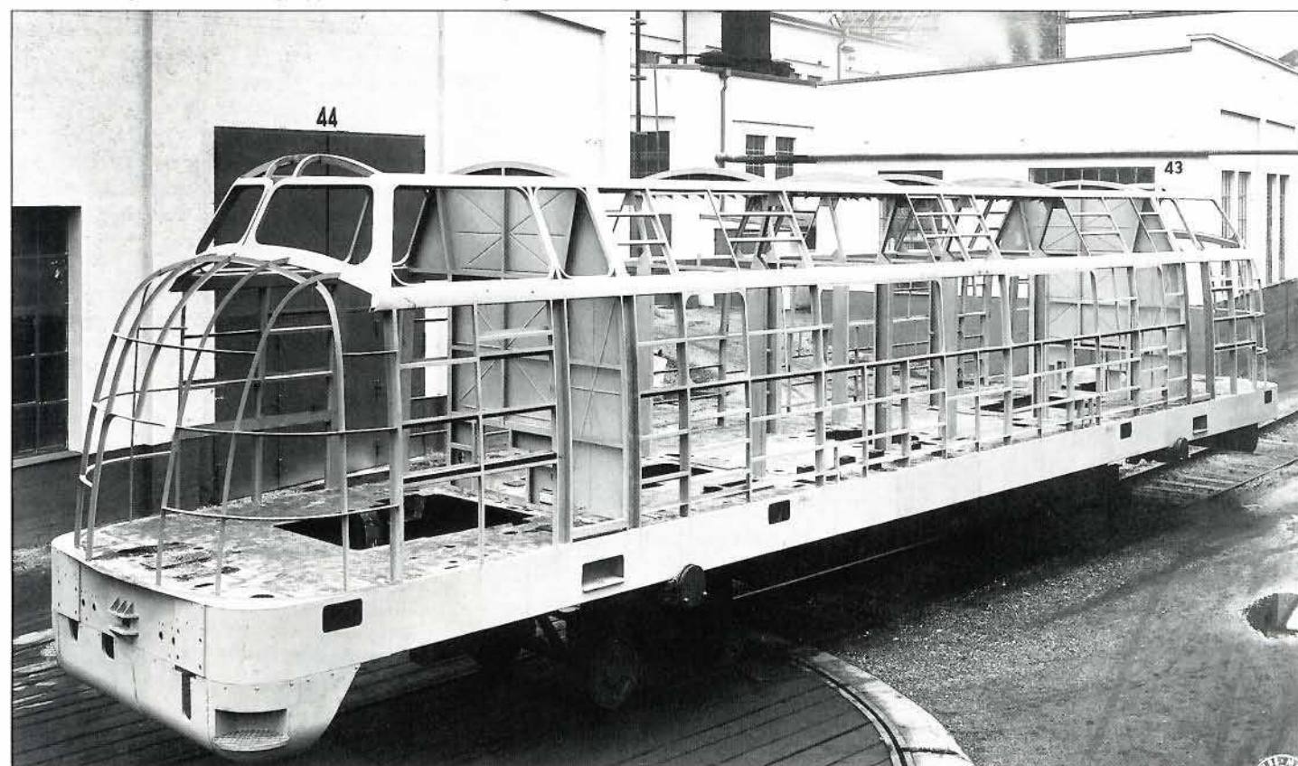
Bild 12: Untergestell mit Aufbaugerippe vor der Verblechung. Werkfoto Krauss-Maffei
