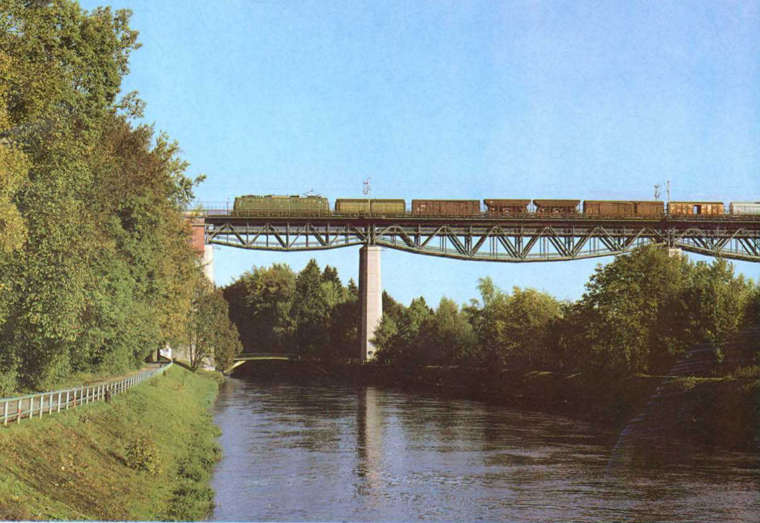
Bild 3: Eine Lokomotive der Baureihe 150 mit einem Güterzug nach München-Laim am 14. Oktober 1982 auf der alten Großhesseloher Brücke (Strecke Holzkirchen – München). Ende letzten Jahres wurde nördlich der Brücke eine eingleisige Behelfsbrücke erstellt und die alte Brückenkonstruktion abgetragen. Mit dem Neubau der Brücke wurde im Frühjahr dieses Jahres begonnen. Foto: A. Ritz
