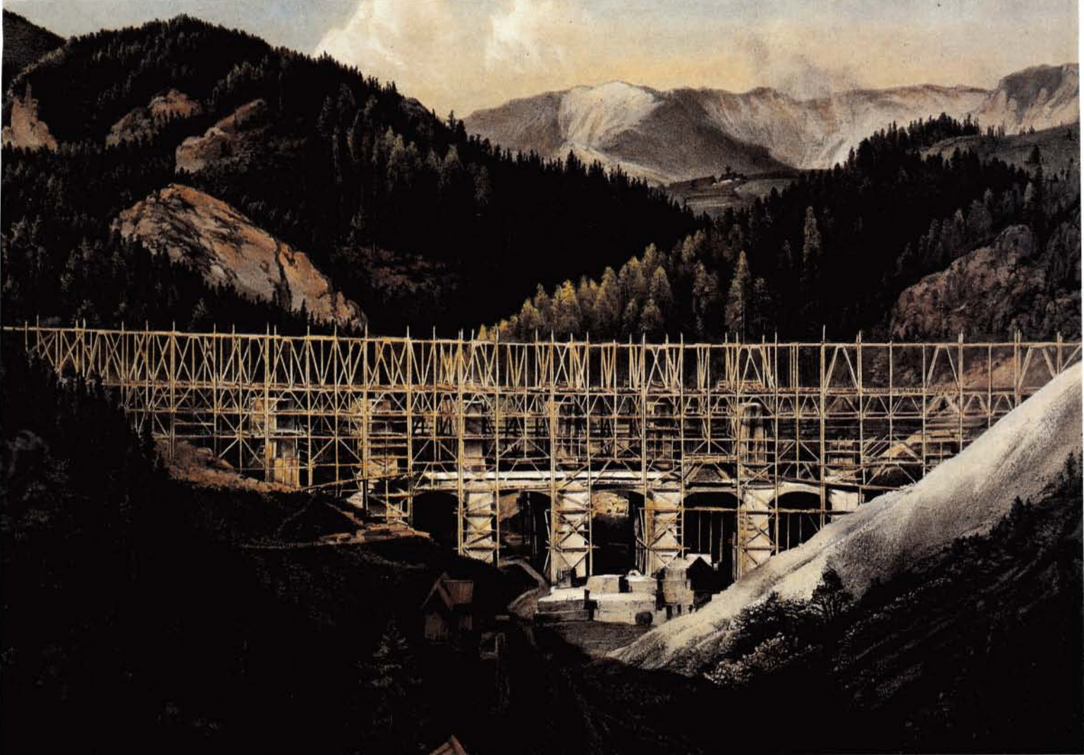
Bild 7: Diese Abbildung veranschaulicht, daß bei der Erstellung der zahlreichen Viadukte der Semmeringbahn zunächst Gerüste mit beachtlichen Ausmaßen errichtet werden mußten (hier der Viadukt über die Kalte Rinne).
