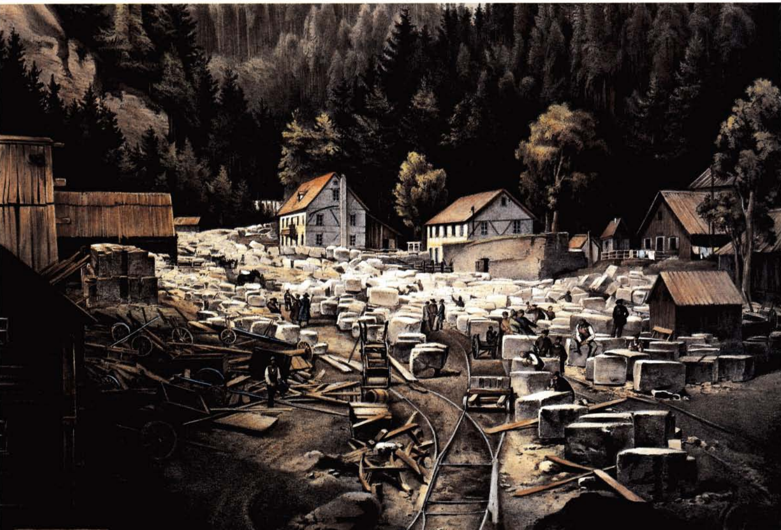
Bild 8: Viele Baustellenlager wurden für den Bau der Semmeringbahn eingerichtet. Mitte des vergangenen Jahrhunderts wurden auch bei Projekten dieser Größenordnung kaum Maschinen als Hilfsmittel eingesetzt; Handarbeit dominierte. Abbildungen: Sammlung Heless
