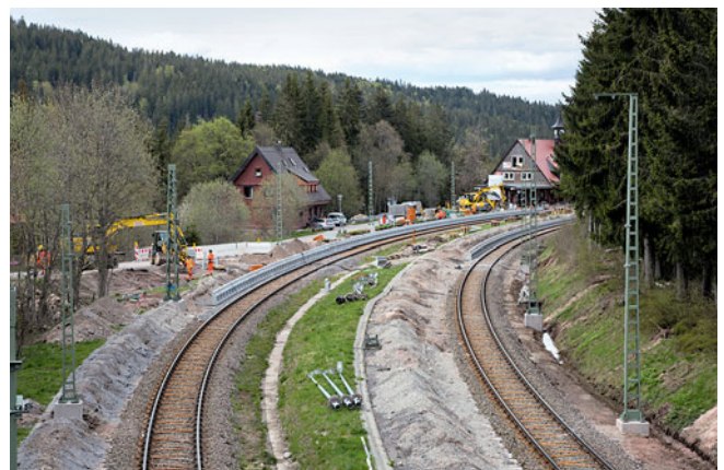
Neue Oberleitungsmasten, neue Bahnsteige: Der Bahnhof Feldberg-Bärenthal an der Dreiseenbahn wurde von Grund auf erneuert, Fahrgäste mussten mit dem Bus vorlieb nehmen. FOTO: MALTE WERNING
