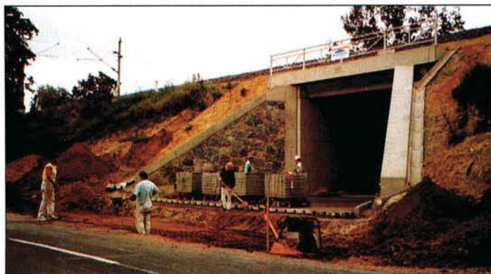
Ausbautrecke Berlin-Hamburg: Bei Breddin wird der Beton eines Durchlasses mit Naturstein verblendet.
