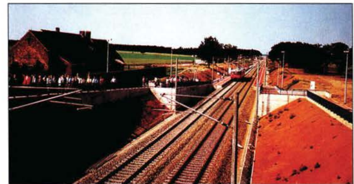
Ausbaustrecke Berlin-Halle/Leipzig: Streckenabschnitt für 200 km/h mit neuem Haltepunkt Bülzig nach beseitigtem schienengleichen Wegübergang.
