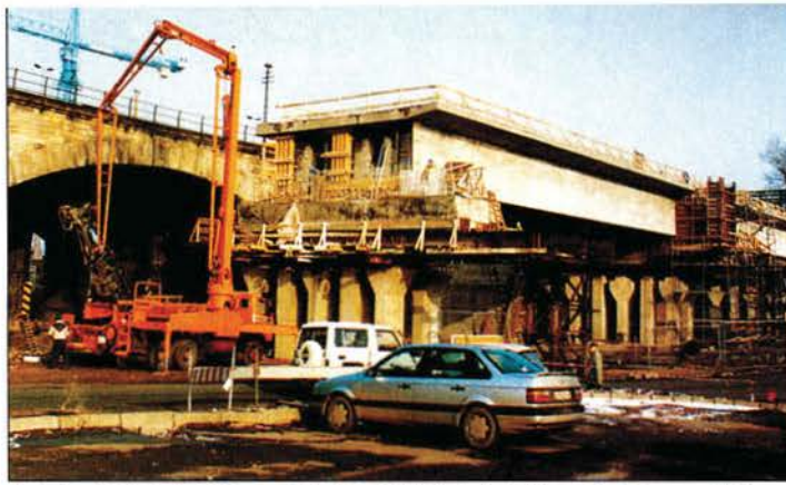
Auf der Ausbaustrecke von Erfurt nach Bebra: In Gotha werden neue Brückenteile eingeschoben als Ersatz für das alte Viadukt (1992).
