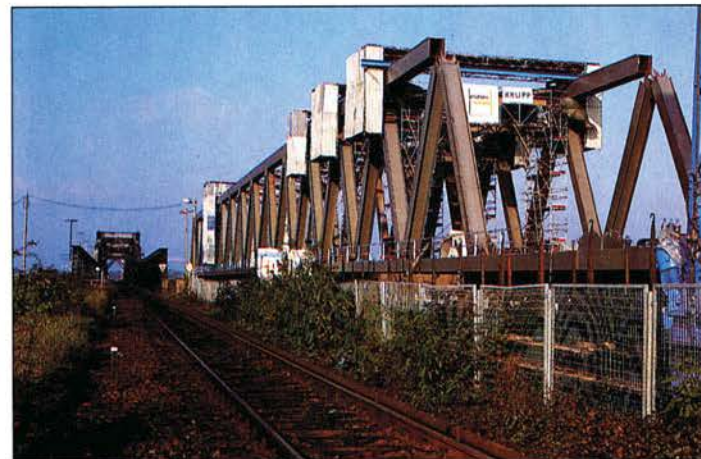
Neubaustrecke Staaken - Oebisfelde: Brücke für 250 km/h über die Elbe bei Hämerten (Stendal). Im Hintergrund die alte Brücke der Stammstrecke.
