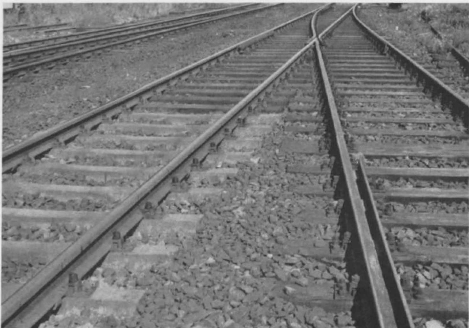
Abb. 1. Der Übergang vom Betonschwellengleis zum normalen Holzschwellengleis. Deutlich fällt auf, daß die Holzschwelle breiter ist (25 cm) als die Betonschwelle (15 cm) und ebenso deutlich ist zu erkennen, daß die Befestigung unterschiedlich ist: bei der Holzschwelle wird die Unterlagsplatte von zwei Schrauben, bei der Betonschwelle nur von einer Schraube gehalten.
