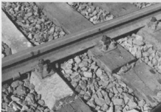
Abb. 1. Der Übergang vom Betonschwellengleis zum normalen Holzschwellengleis. Deutlich fällt auf, daß die Holzschwelle breiter ist (25 cm) als die Betonschwelle (15 cm) und ebenso deutlich ist zu erkennen, daß die Befestigung unterschiedlich ist: bei der Holzschwelle wird die Unterlagsplatte von zwei Schrauben, bei der Betonschwelle nur von einer Schraube gehalten.
