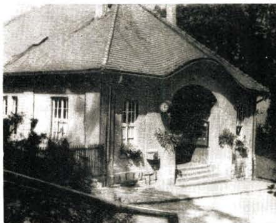
Bild 4 Das obere Stationsgebäude, in dessen linken Teil die Verwaltung und ein Aufenthaltsraum für die Bahnangestellten untergebracht sind
