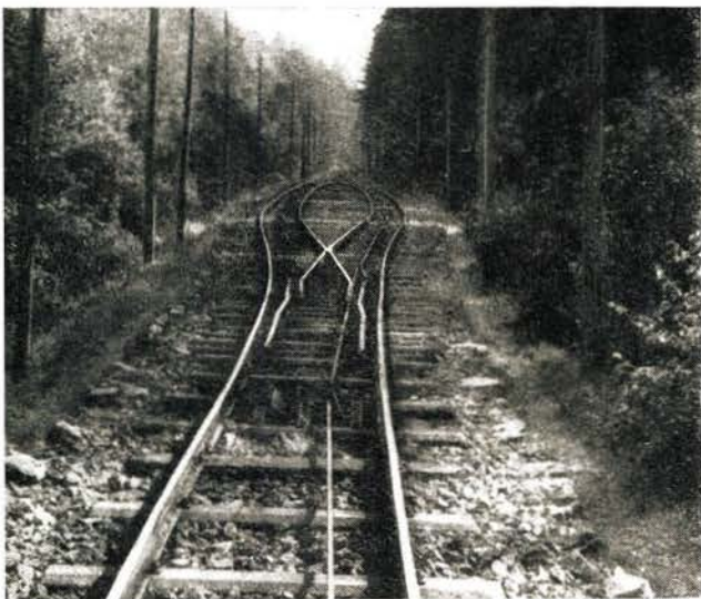
Bild 2 Die Kreuzungsstelle mit zungenlosen Abt'schen Weichen
