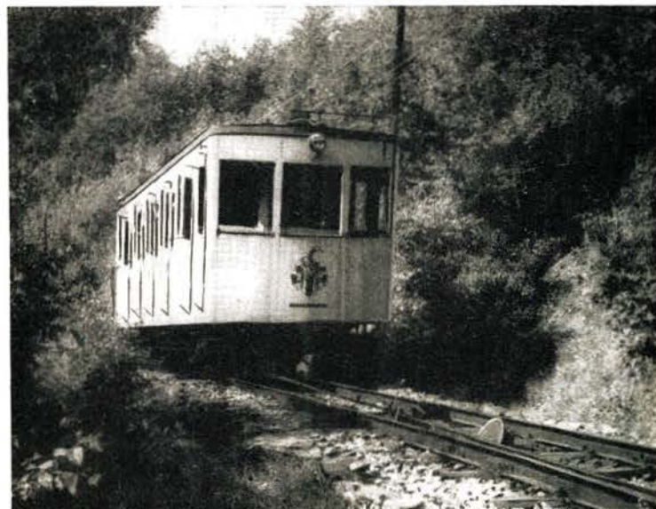
Bild 5 Ein Wagen der Standseilbahn in dem Einschnitt zwischen km 0,2 und 0,3
