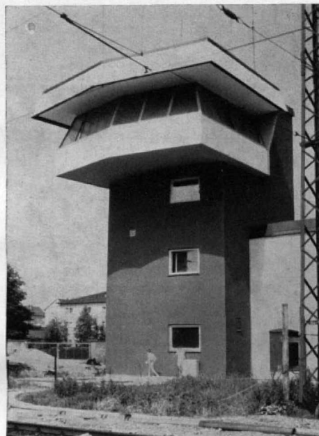
Abb. 1. Noch moderner als die Kibri-Version bietet sich das Original dar: das neue DB-Stellwerk in Neu-Ulm. Die starke Neigung der Fensterflächen nach innen ist gut zu sehen. Über die ultramoderne Architektur dieses Bauwerkes kann man geteilter Meinung sein; wichtig wirkt es auf jeden Fall. (Foto: H. Rothärmel, Ulm)
