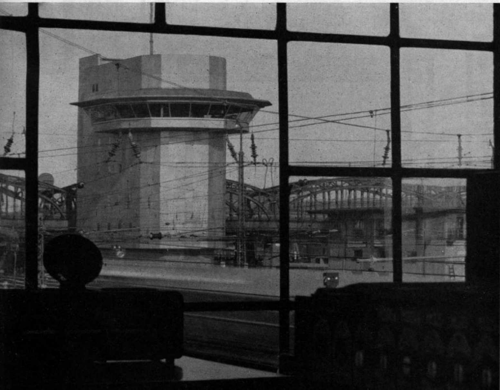
Abb. 2. Das neue Zentralstellwerk in München, von einem der bisherigen alten Stellwerke aus gesehen. Im Vergleich mit den Fenstern der neuen Stellwerke wird deutlich, welcher Fortschritt hinsichtlich des Ausblickes auf die Gleisanlagen erzielt wurde (vom „gehobenen Standpunktniveau“ und dem großen Rundblick mal ganz abgesehen). Die Rahmen der kleinen Fensterscheiben irritieren doch sehr und nicht immer hat der Stellwerksbeamte die Möglichkeit wie der Fotograf, das Objekt durch die größere Scheibe anzuvisieren. Auch unser Titelbild zeigt das neue Zentralstellwerk München. (Foto: DB/Siemens)
