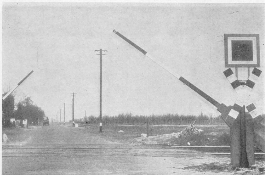
Abb. 5. So sehen die neuen Halbschranken aus, die von der Bundesbahn versuchsweise aufgestellt werden. Die zugehörigen Warnkreuze und Warnlichter entsprechen denen aus Heft 15/VI, S. 579 ff.
