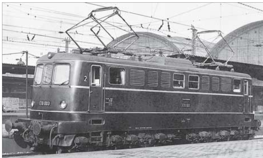
Rechts: E 10 003 befand sich gerade im AW Freimann, als diese Dachaufnahme entstand. Aus der Abbildung geht die Anordnung der Dachrüstung hervor, wie sie für unseren Umbauvorschlag gestaltet werden muss. Foto: Slg. Zöllner
