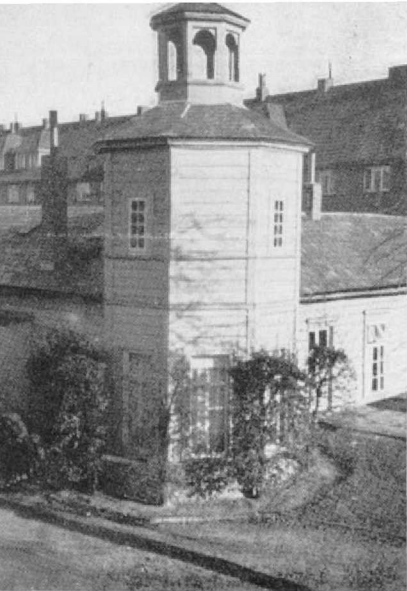
Abb. 5. Ansicht des Turmes im derzeitigen Zustand.
