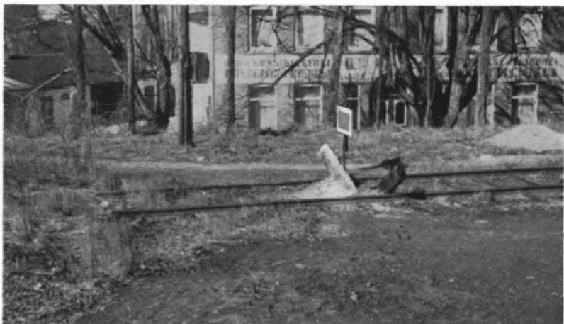
Abb. 3. Ein provisorischer Prellbock im Bf. Neumünster, der mit einem Schutzhalt-Signal gekennzeichnet ist, das offenbar auch nach hinten eine rote Fläche zeigt oder verkehrt 'rum eingesteckt worden ist.
