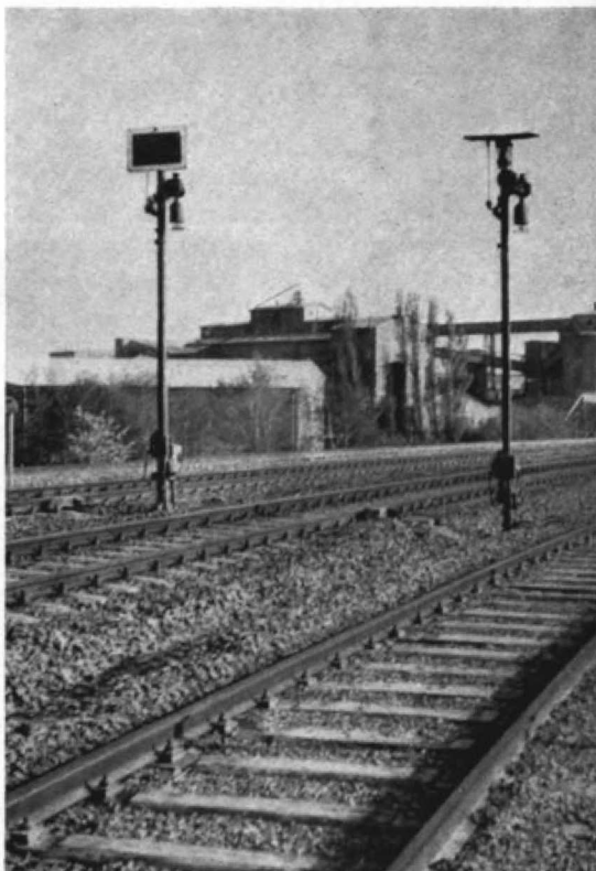
Abb. 4 und 5. Zwei ortsfeste Deckungssignale mit kippbaren Scheiben und Nachtzeichen vor (und natürlich auch hinter) einer Drehbrücke über die Stör. Die Magnetkästen neben den Schienen lassen auf eine Indus- Sicherung schließen. (Fotos: H. Wiener, Brunsbüttelkoog)
