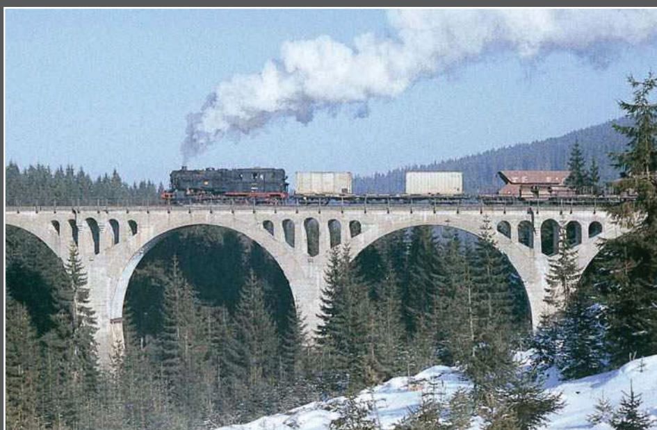
Eine unbekannte 95 mit Neubaukessel des Raw Meiningen auf dem Viadukt im Finstren Grund zwischen Probstzella und Lauscha. Wiederum wird ein Nahgüterzug Richtung Lauscha befördert. Der Viadukt ist ein Stempfbetonbauwerk aus der Zeit vor dem Ersten Weltkrieg, dessen Erhaltung immer erhebliche Probleme bereitete und letztendlich mit ein Grund für die plötzliche Stilllegung der gesamten Strecke am 22. Januar 1997 wurde. Unsere Aufnahme vom 2. Dezember 1973 entstand bei bestem Sonnenschein. Starker Wind hat den Schnee von den umliegenden Bäumen gefegt. Ein hochinteressantes Motiv für den Modellbauer! Anlagen mit Winterszenen wirken oft zuckerbäckerhaft oder kalt und unnahbar. Nadelbäume ohne Schneebedeckung machen sie wieder lebendig. Dass eine solche Situation wirklichkeitsgetreu ist, beweist unser Foto.
